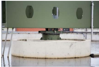
Zentraler Drehkranz mit automatisierter Schmiertechnik
