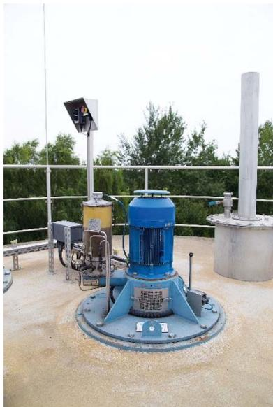
Rührwerk Faulturm mit Zentralschmieranlage
