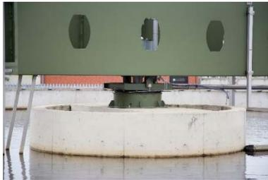
Zentraler Drehkranz mit automatisierter Schmiertechnik
